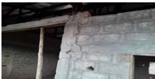
Construction d'un module de 3 classes en souffrance ( GahBakka /Sinendé)
