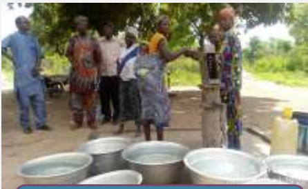
Réparation d'une pompe dans la commune de Tchaourou
